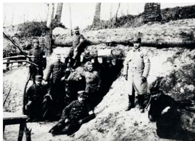
Entrée d'un abri souterrain (1918)
