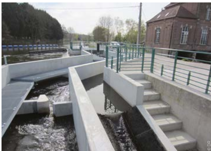
◀ Aménagements d'une passe à poissons et à anguilles au niveau de l'écluse de Long sur le fleuve pour rétablir la continuité écologique avec notamment le passage des poissons.
