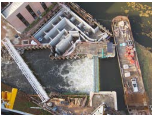
◀ Travaux sur le barrage du Pendu à Amiens avec installation d'une passe à poissons et à anguilles.
