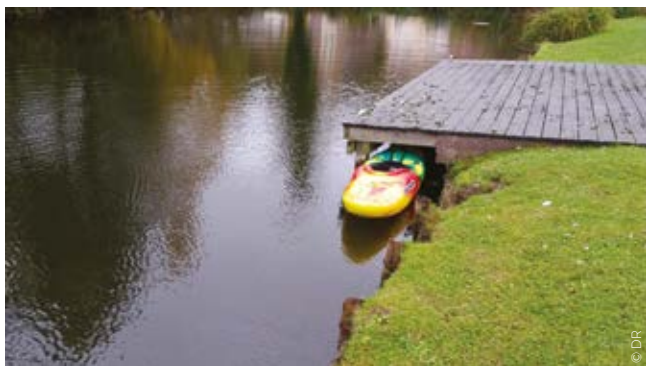
L'installation d'aménagements, comme des pontons, permet de limiter les dégradations sur les berges dues aux activités nautiques. Les circuits doivent aussi être sélectionnés dans l'optique de limiter le dérangement.
