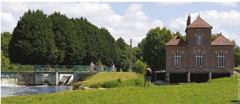
Figure 69 : Centrale hydroélectrique de Long, une des premières construites en France. Elle est toujours en activité à ce jour. Une passe à poissons (à gauche) permet de maintenir la continuité écologique.
