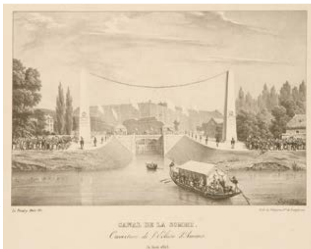
◀ Figure 47 : Canal de la Somme : Ouverture de l'écluse d'Amiens en 1825.
