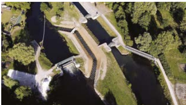
Aménagement d'une rivière de contournement pour rétablir la continuité écologique au niveau de Pont-Rémy.
