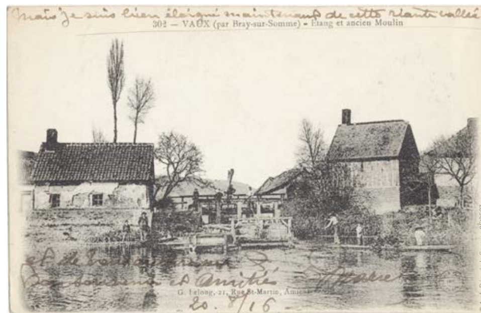
Figure 45 : Étangs et ancien moulin au niveau de la chaussée-barrage de Vaux. Aujourd'hui, le moulin est détruit mais la chaussée barrage est toujours présente.
