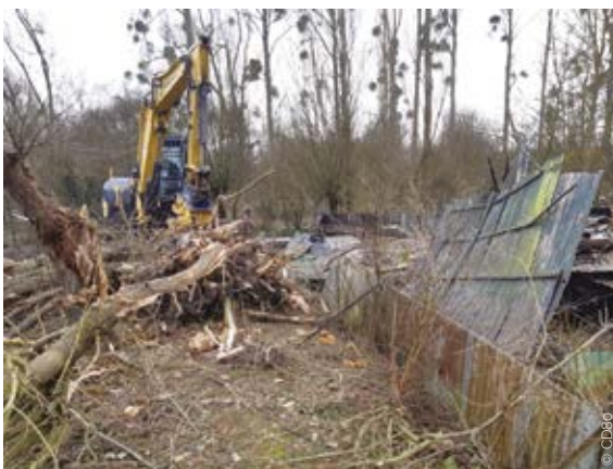
Destruction d'anciens cabanons, non stables, sur un Espace Naturel Sensible acquis par le Département.
