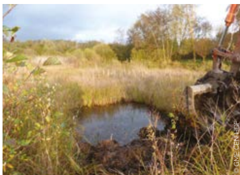
◀ Creusement de gouilles à la pelle dans la RNN de Boves pour la restauration d'habitats.
