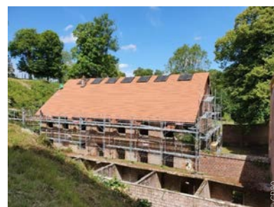
Réfection de la couverture prison des femmes - Citadelle de Doullens
