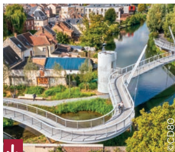
Réalisation de la passerelle l'Hortillonne pour connecter le centre-ville d'Amiens à la Véloroute Vallée de Somme
