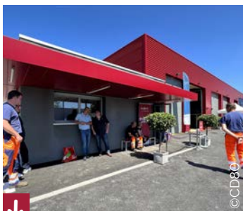
Un centre d'exploitation routière départemental inauguré à Crécy-en-Ponthieu
