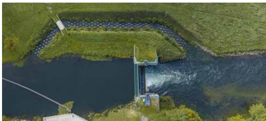
► Écluse de Pont-Rémy avec passe à poissons
