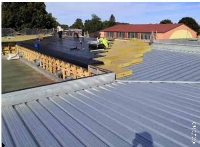
► Isolation de la toiture du collège de Ailly-le-Haut-Clocher
