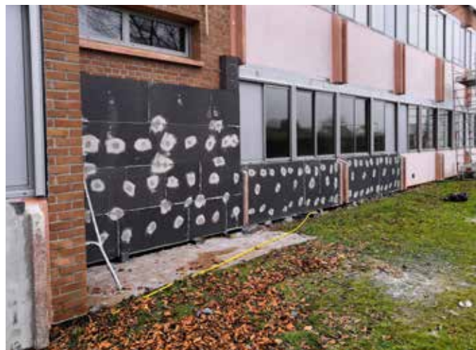
► Travaux d'isolation du collège de Novion
