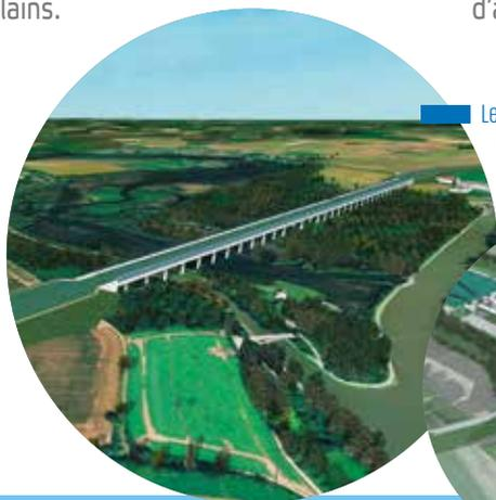
Le Pont-Canal de la Somme sera un ouvrage exceptionnel de 1330 m de longueur, 30 m de largeur, positionné 24 m au-dessus de la Somme
