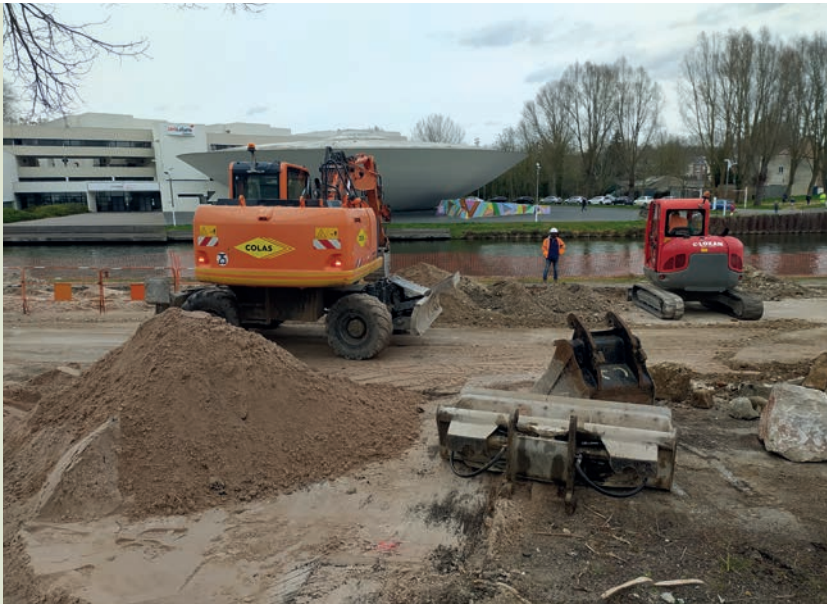
Travaux du Port d'Aval
