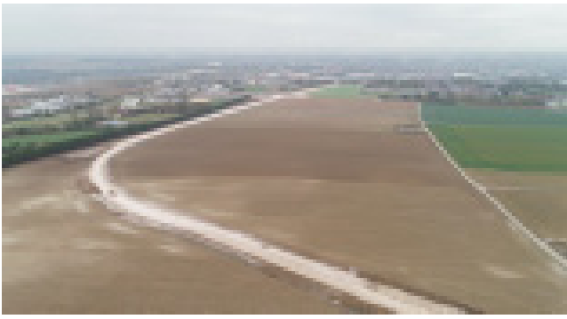
Création d'un barreau d'accès au CHU à Amiens.
