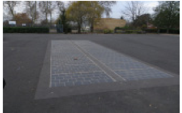
Expérimentation de la route solaire dans la cour du collège Edouard Lucas à Amiens.
