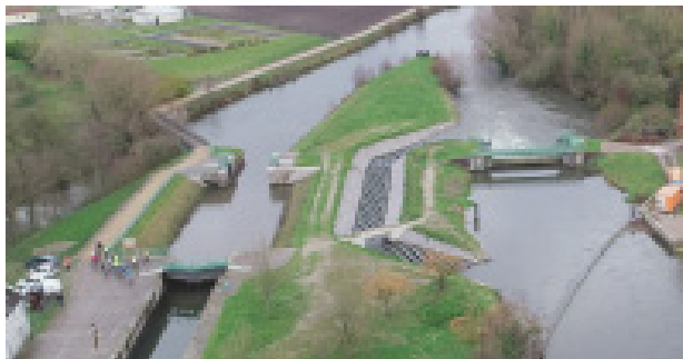
Création d'une rivière artificielle à Pont Rémy.
