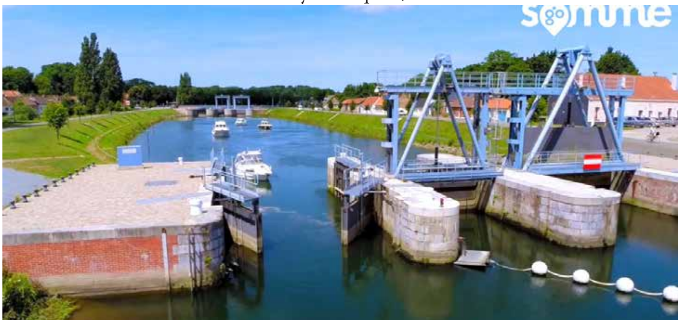
Barrage - écluse à Saint-Valery-sur-Somme (© Somme Tourisme)
