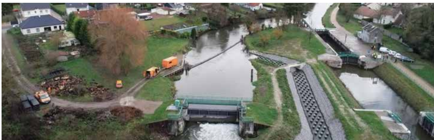
Rénovation de l'écluse et création d'une rivière artificielle à Pont-Rémy (© CD 80)
