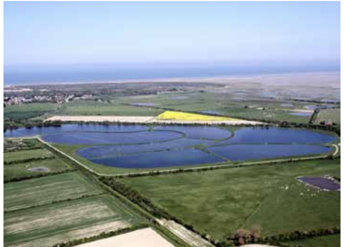
La station d'épuration par lagunage de Fort-Mahon
