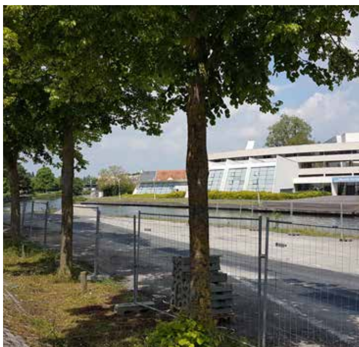
Le site du futur relais nautique à l'aval de l'usine Saint-Michel
