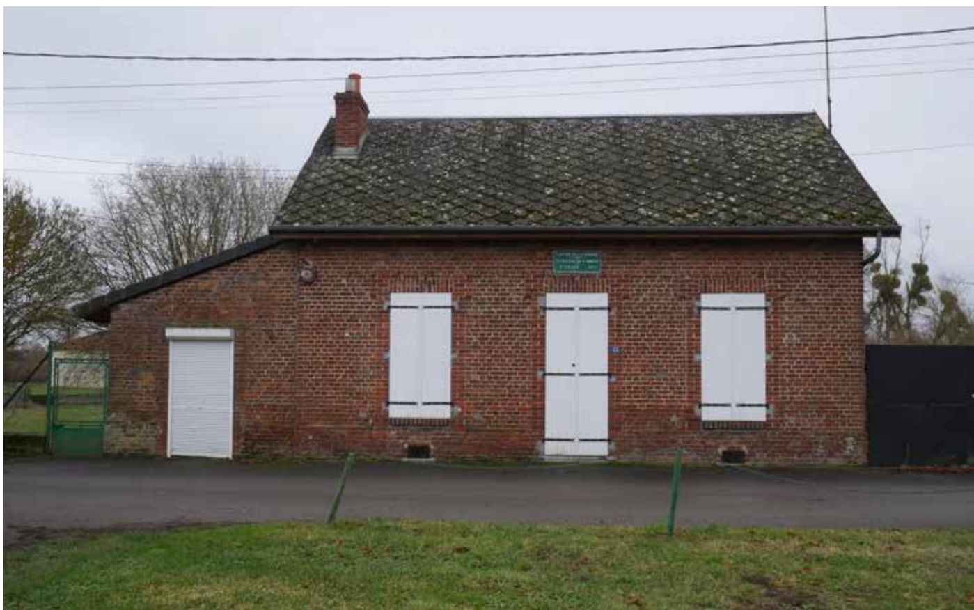
Maison éclusière de Saint-Simon au « Point Y » : point de départ du Canal de la Somme
