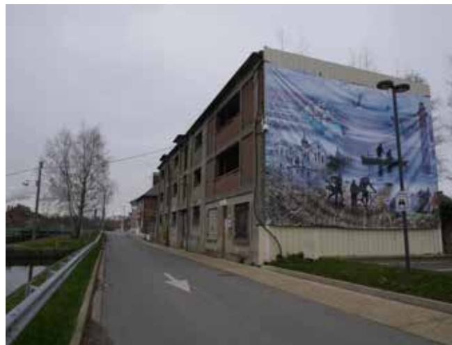
Une ancienne usine à réinvestir face à l'écluse de Ham
