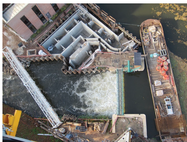
Création d'une passe à poissons et à anguilles au niveau du Pendu à Amiens.
