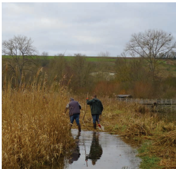
Les chantiers d'insertions permettent de former sur les techniques d'entretien tout en réalisant des travaux sur les sites.
