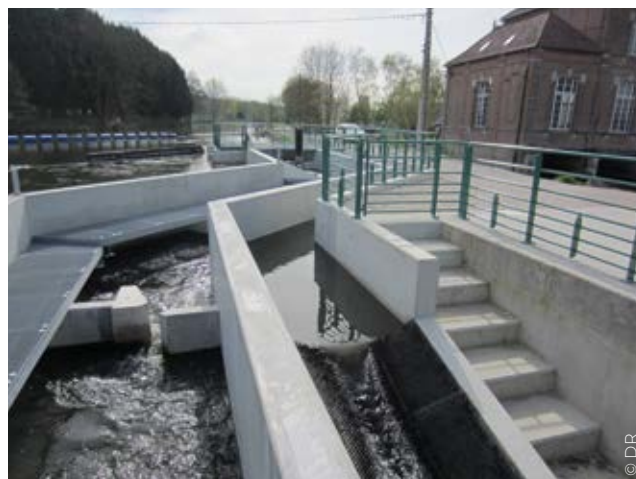
Passes à poissons et à anguilles au niveau de Long
