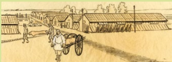
Hôpital d'évacuation du front (H.O.E. 15 - Gailly-Cerisy)
