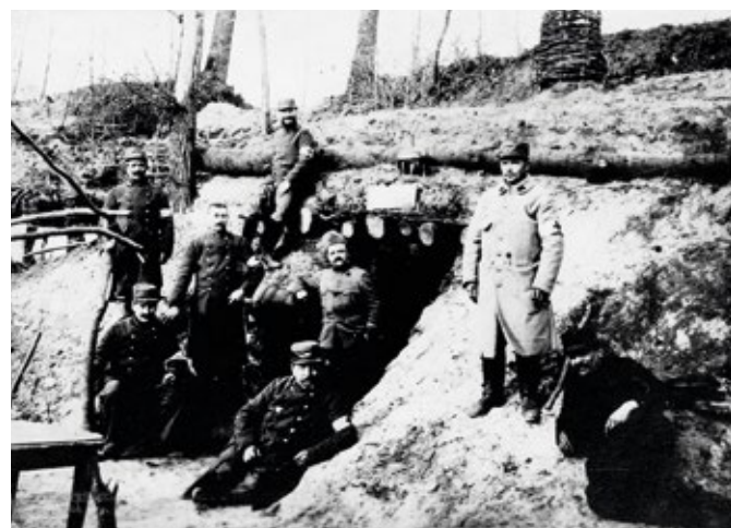
Entrée d'un abri souterrain (1918)
